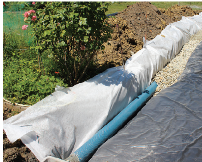
Béchade A.F., La pathologie des fondations superficielles : Diagnostic, réparations et prévention, ©CSTB Editions/AQC, 2021
